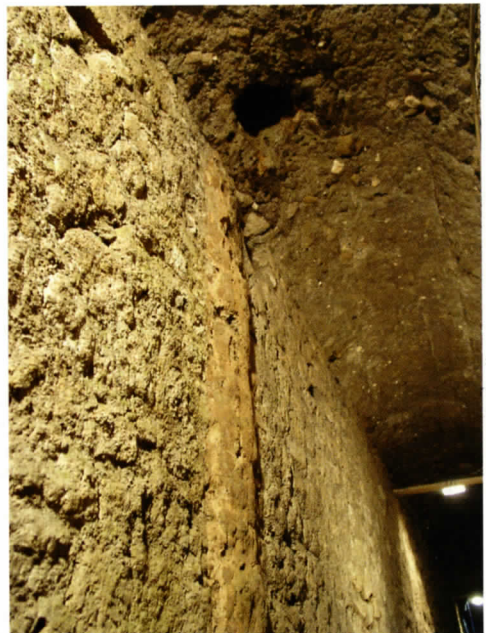
Fig 6.24. Ercolano, Lo scarico di una latrina all'interno della fossa settica dell' Insula Orientalis II . Si riconosce la striscia di materiale organico ancora conservato lungo la parete del condotto (foto D. Camardo).
